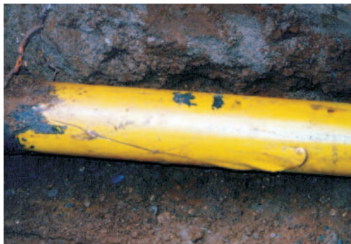
Bild 9: Beispiel einer Umhüllungsfehlstelle aufgrund von Fremdeinwirkungen
