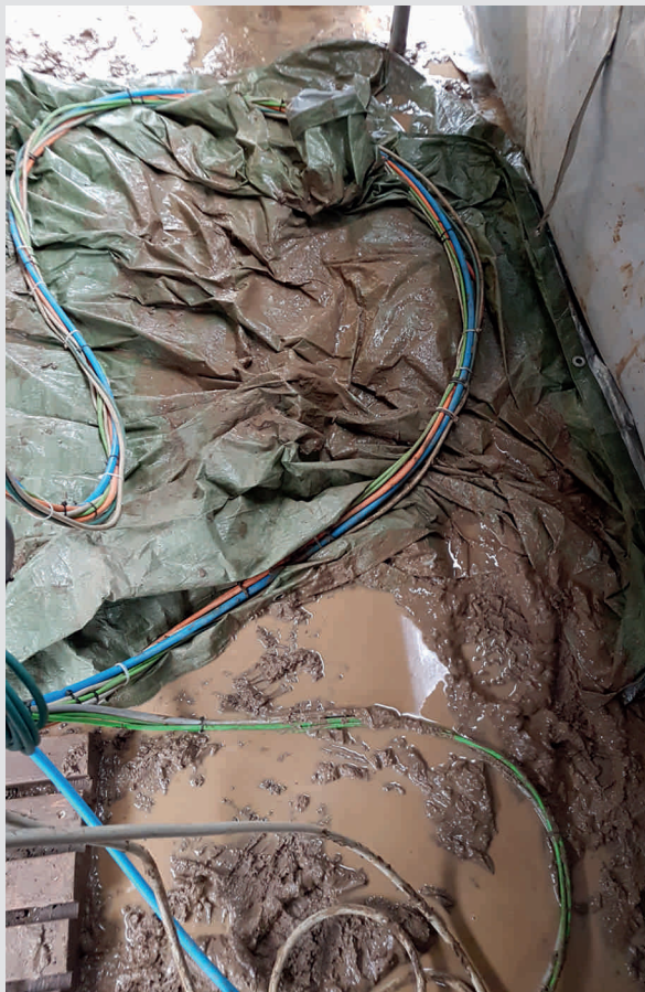
Bild 10: Lichtleitfaser Schlauchpaket im durchnässten Boden
