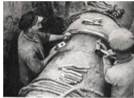
Bild 3: Montage und beispielhafte Ausführungen der Stemmuffe [2]
