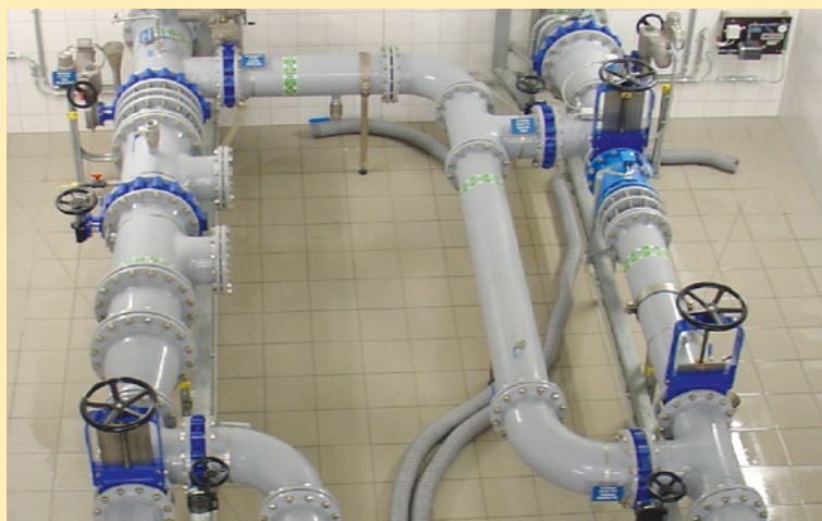
Bild 2. Polyamidbeschichtete Rohre in einer Schieberstation für Trinkwasser.
