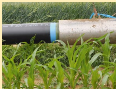
Bild 18. Pflugverlegung einer Wassertransportleitung der Wasserversorgung Bayerischer Wald.
