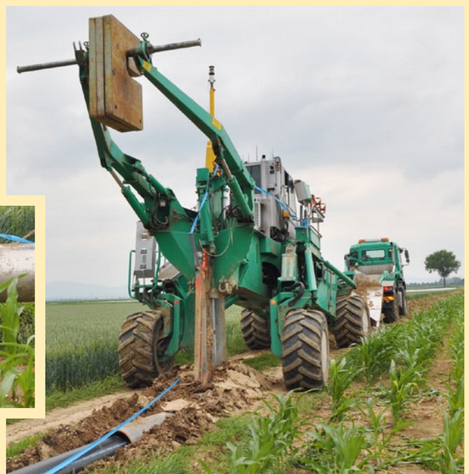
Pflügen des Rohrstranges ▼
