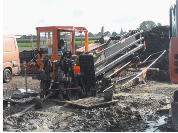
Bild 16. Pilotverlegung eines polyamid- umhüllten Rohres mit dem Spülbohr- verfahren.
