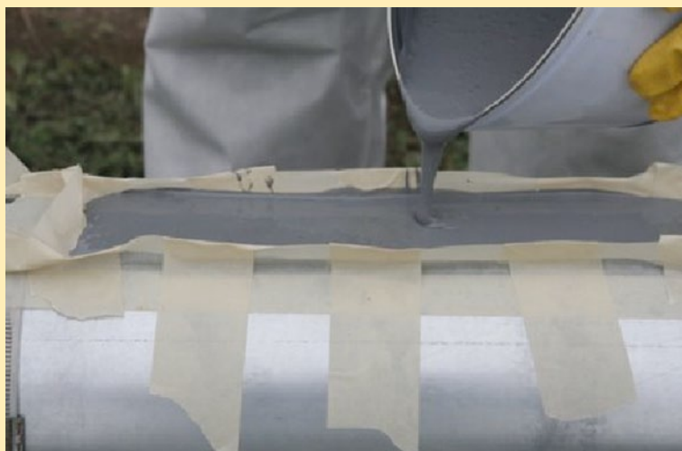
Bild 3. Die Nachumhüllung aus Polyurethan (Vergussystem).
