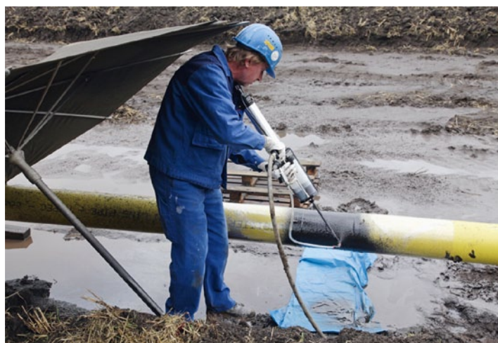
Bild 15. Nachumhüllung der Schweißnähte mit einer Polyurethanbeschichtung.
