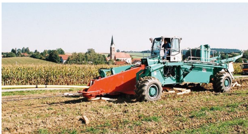
Bild 20. Pflügen einer Rohrleitung.
