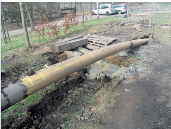
BILD 15: Nachumhüllung der Schweißnähte mit einer Polyurethanbeschichtung
