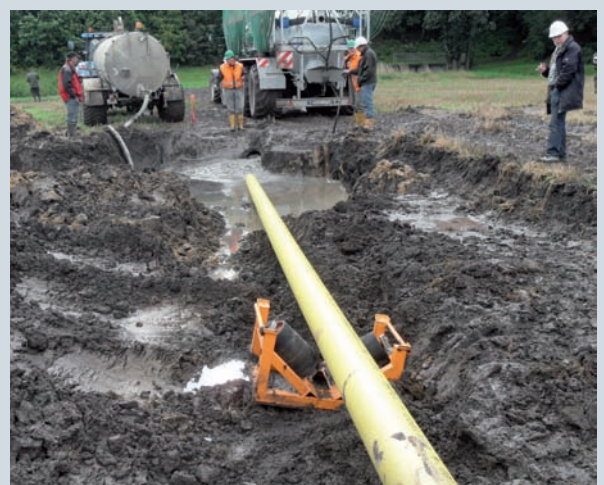
BILD 16: Pilotverlegung eines Polyamidumhüllten Rohres mit dem Spülbohrverfahren
