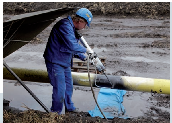
BILD 15: Nachumhüllung der Schweißnähte mit einer Polyurethanbeschichtung
