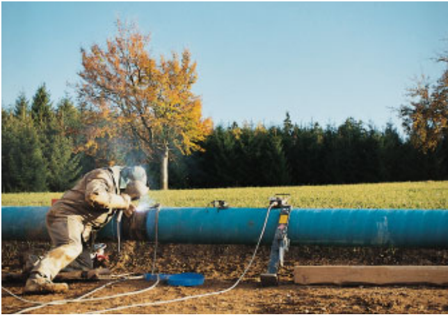
Abb. 9: Verschweißen der Rohre
