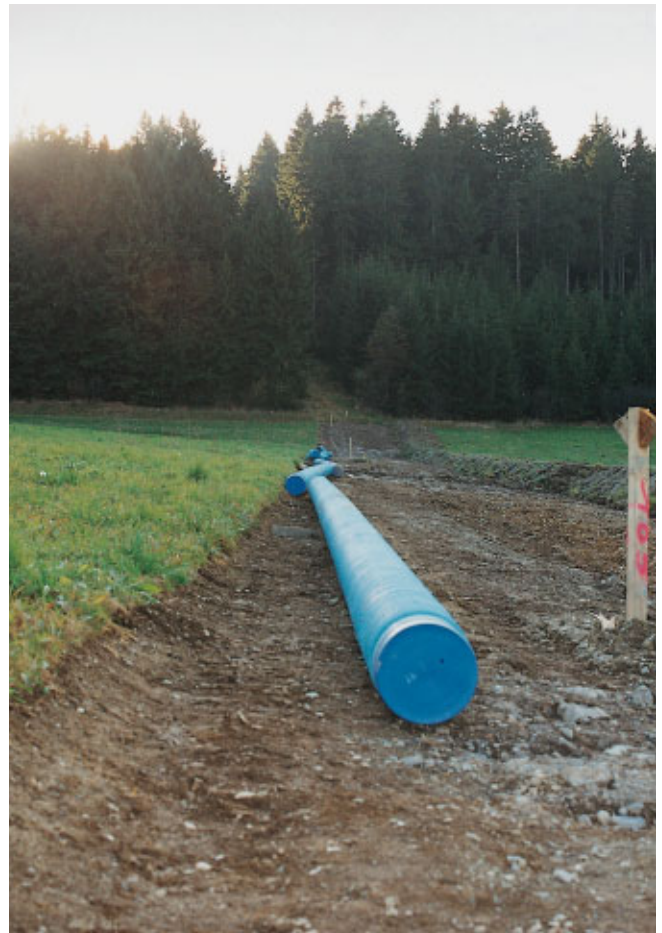
Abb. 8: Auslegen der Rohre
