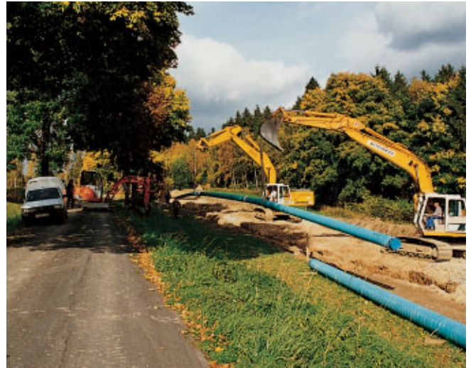
Abb. 10: Absenken eines Leitungsabschnittes
