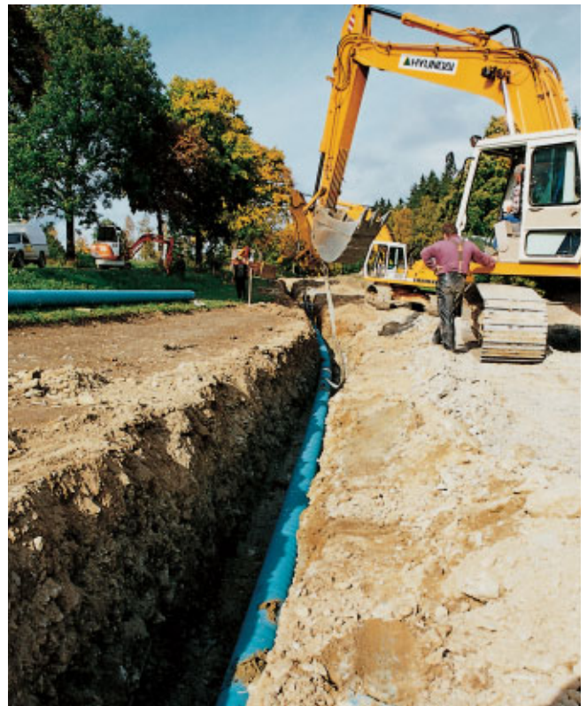
Abb. 11: Richtungsänderung unter Ausnutzung der elastischen Biegung
