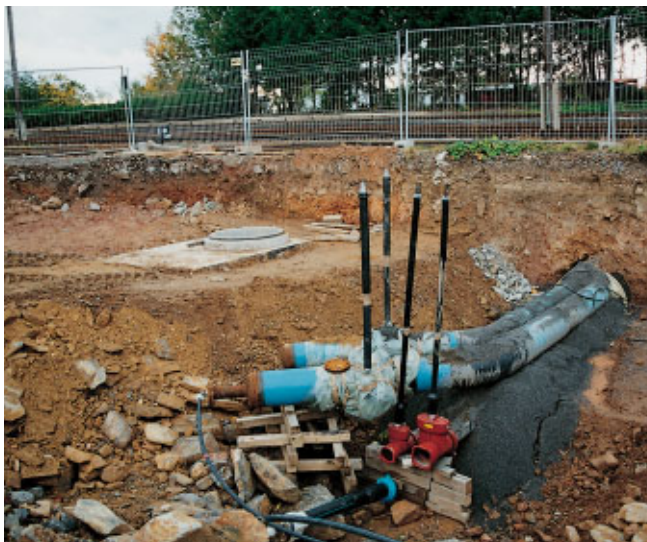
Abb. 12: Unterpressung eines Bahndammes
