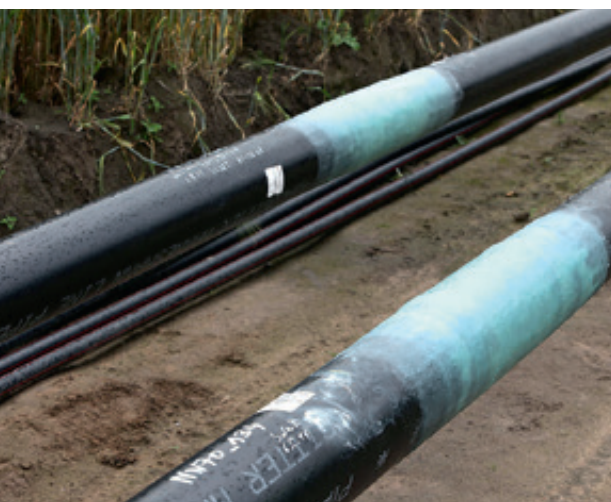
Abb. 7 – Beim Projekt Zephir kommt für die Nachumhüllung ein kombiniertes PE-/GfK-System zum Einsatz.
