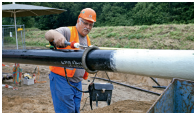
▲ Abb. 3 – Beim Einzug eines Rohrstranges prüfen die Rohrbauer grundsätzlich die Qualität der Umhüllung mit einem speziellen Test.
